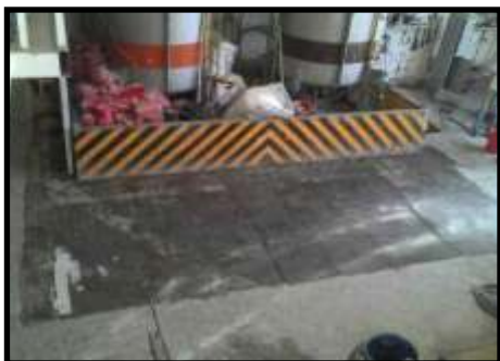
Secado de 24 horas 21°C a 60% de humedad ambiental
